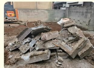
建物の土台として残ったコンクリート。木造でも鉄筋コンクリート並みの“深基礎”が残っているケースあり。
