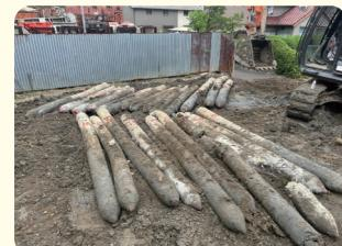
地盤補強のため地中に埋められた杭。コンクリート杭・鋼管杭など。撤去は大掛かりで費用増大に
